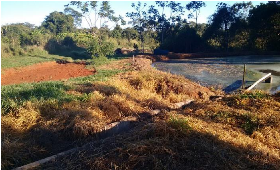
Local de instalação dos sistemas alagados construídos.
